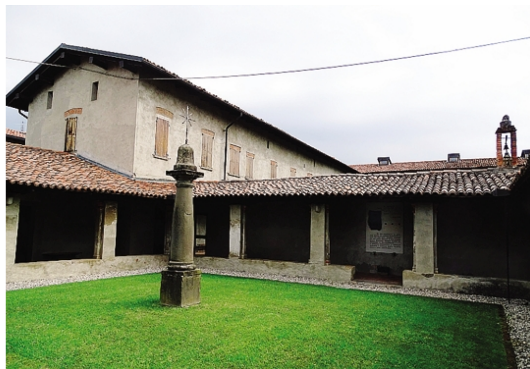
La zona del convento di Baccanello dove verranno realizzati gli alloggi per i padri separati
